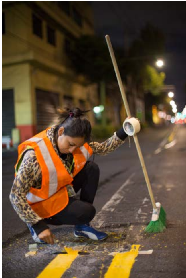
1 RETIRO DE PINTURA
